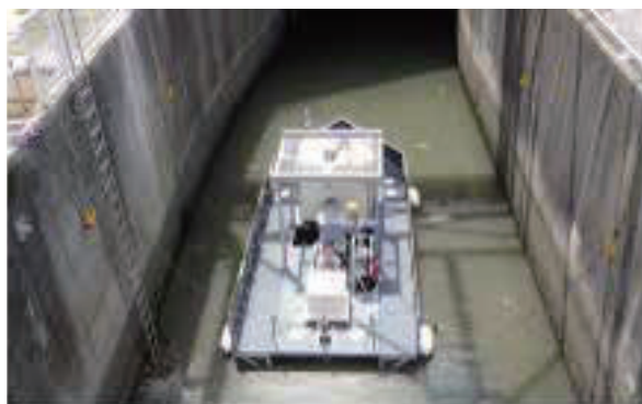
河川に設置した水質改善装置
